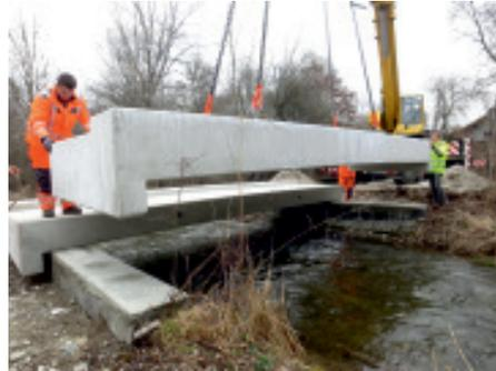
Am Westufer des Auensees wurde eine neue Brücke installiert. Die Bauhofmitarbeiter leisteten professionelle Hilfe beim Ausrichten der Betonteile.
